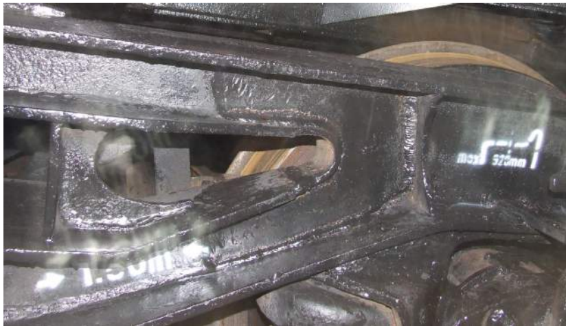
Figura 4.11. Lonjeron reparat (cu fisuri în cordonul de sudură și crăpături pe inima lonjeronului)
