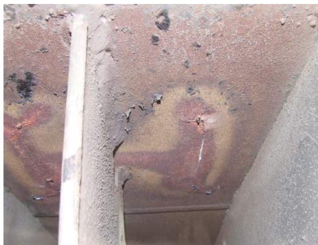
b) Vedere din interiorul traversei
