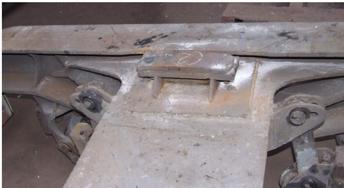
Figura 4.14. Traversa crapodinei (modul de remediere a fisurilor în zona suporturilor glisierelor laterale)
